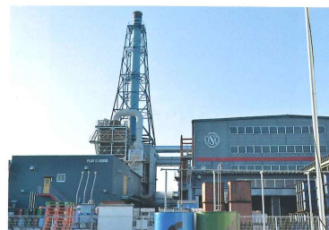
最新鋭の焼却設備を備えた基幹工場である干渉工場
