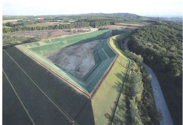
北海道の最終処分場は区画を分けて段階的に設置し、埋立終了後は植樹している
