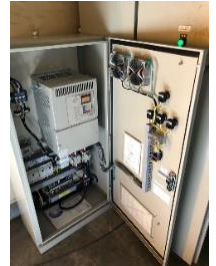
千葉工場 インバータ制御盤
